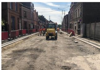
Après la phase d'enfouissement des réseaux basse tension et la réfection de la chaussée du chemin de Meurchin, conduites par la commune, la MEL a engagé depuis la fin du mois de mai les travaux de reconstruction de la voie et des trottoirs. Des aménagements complémentaires permettront la réduction de la vitesse des
