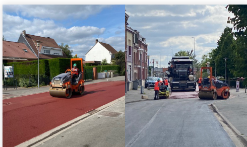
Travaux d'été de réfection de la rue Paul Vaillant Couturier
