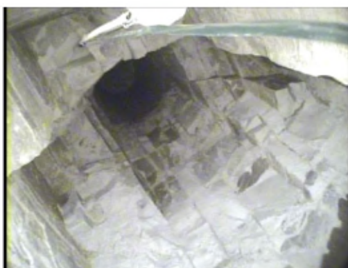
Vue de la tête de catiche, 1.5 m à l'Ouest du forage F01
