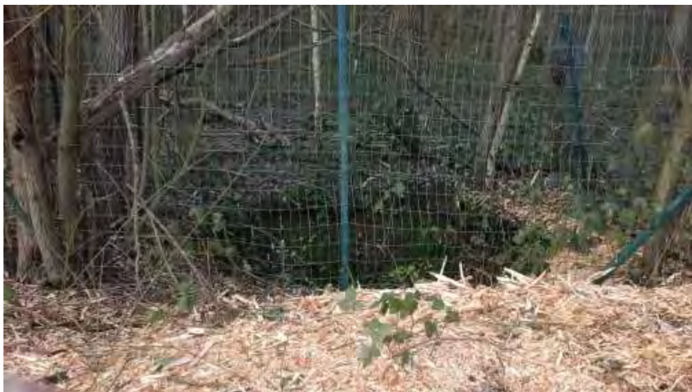
Figure 4 : puits secondaire du secteur sud depuis l'extérieur du dispositif de protection
