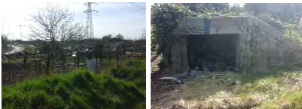
Figure 8 : Jardins familiaux et probable puits d'extraction sécurisé par du béton et comblé de détritux
