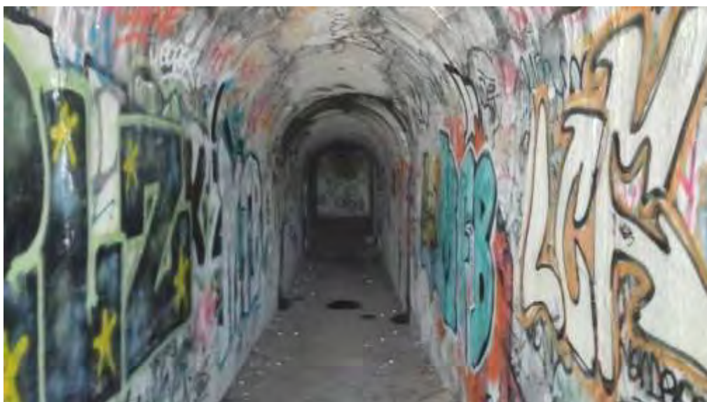
Figure 6 : galerie de l'ancien arsenal
