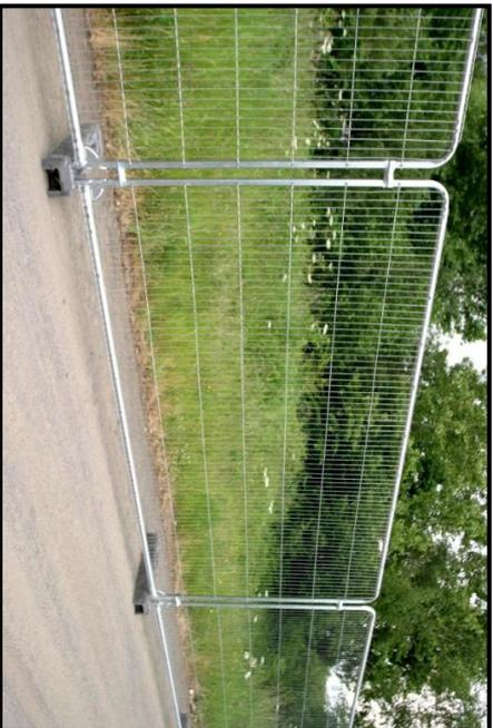
**Photo 8 : Exemple de système de bailisage type rigide (Source : internet)**
